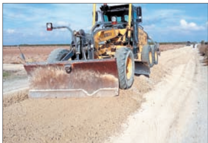
FOTO: Aj. Torrefarrera / Imatge dels treballs, amb àrids reciclats
