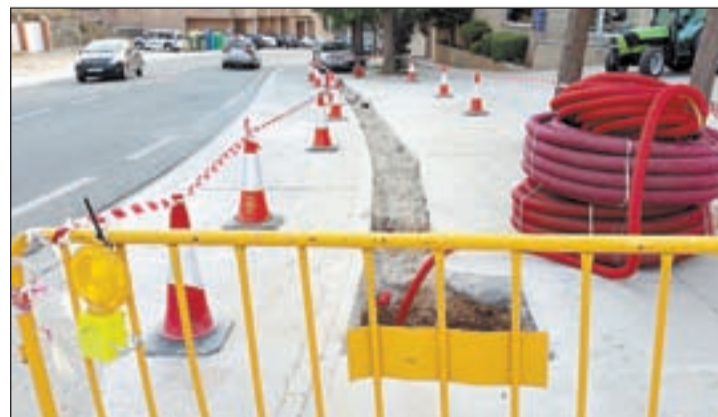
FOTO: Aj. Alcarràs / Imatge de les obres que s'estan realitzant
