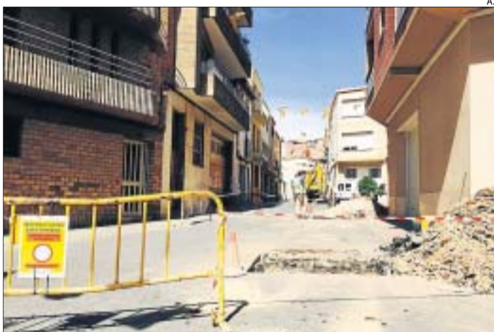
Les obres que es porten a terme al carrer Carretera.
