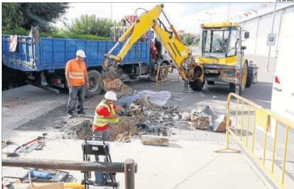
Una excavadora va perforar una canonada en aquestes obres al pàrquing de les piscines.
