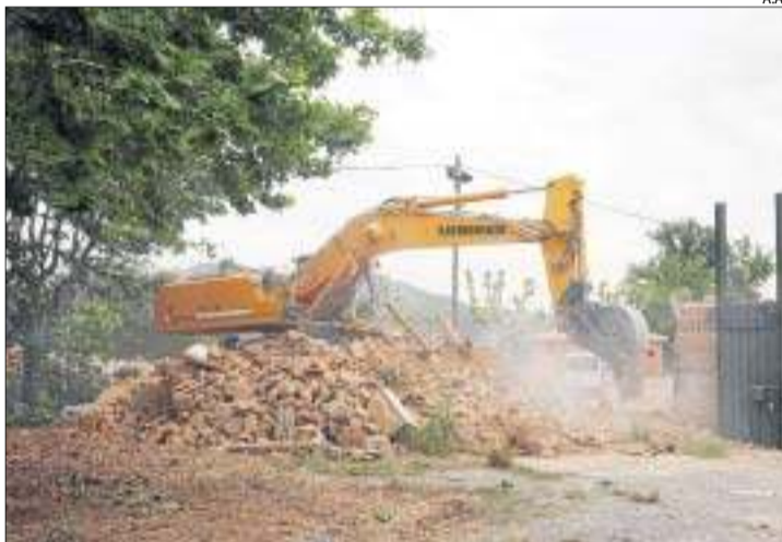
La demolició d'edificis en ruïna de Mitasa d'Alfarràs.
