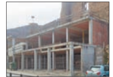
ACN / L'edifici està en obres
