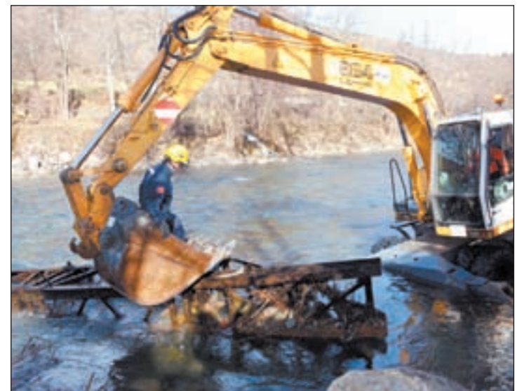
FOTO: Marta Lluich (ACN) / L'excavadora retirant restes del pont
