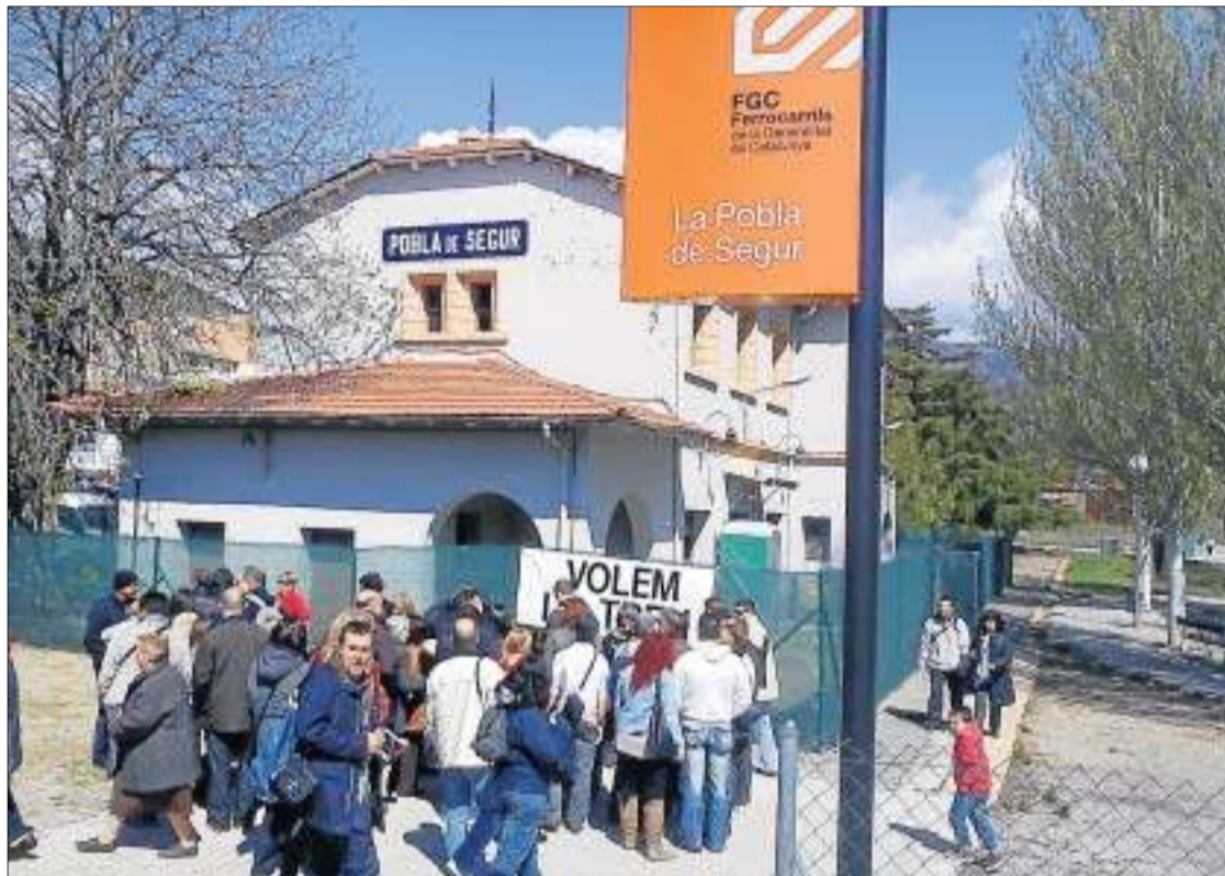
Imatge d'arxiu de l'estació de trens de la Pobla de Segur, clausurada i greument deteriorada.
