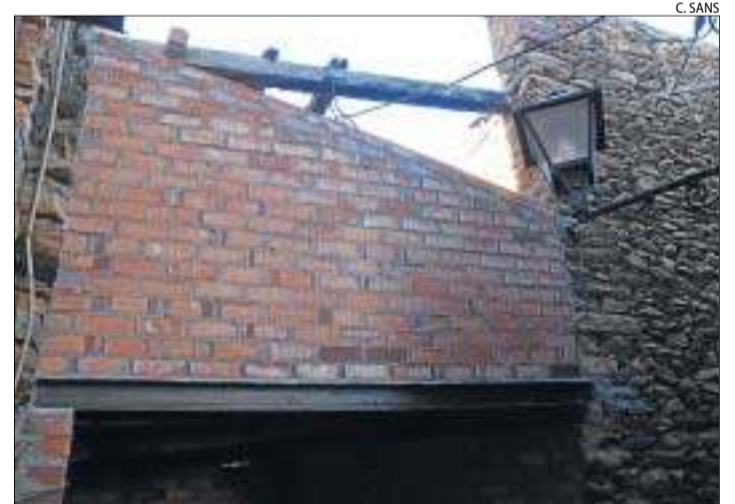
Imatge de les obres d'apuntament de l'immoble.
