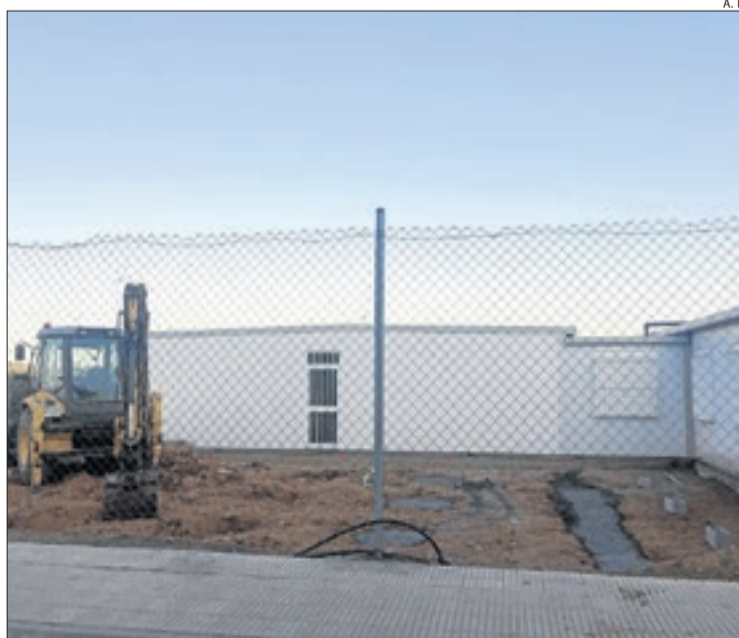
Imatge de les obres de construcció de dos nous barracons.
