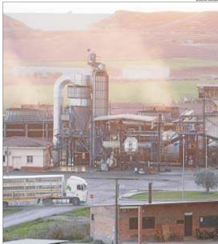
Imatge d'arxiu de la planta de Guascor, a Alcarràs.
